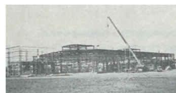
正在建设的群马工厂
