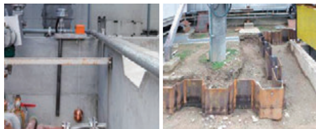
ポンプヤードに設置した2種類のレベルセンサー 地下7mの遮水壁
