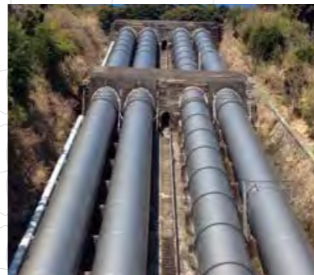
日本軽金属(株)蒲原製造所の発電所用水圧鉄管
