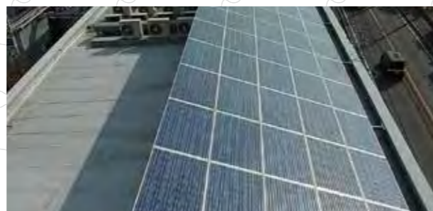
八尾製造所の屋根に設置した太陽電池パネル
