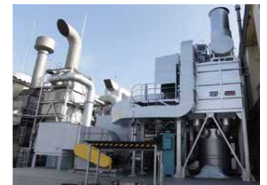
群馬製造所VOC処理装置
