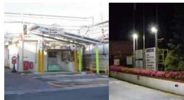
「Hane™モジュール」を設置した八尾製造所カーポート(左)と、それを電源としたLED街灯(右)
