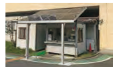
超軽量太陽電池パネル「Hane® Module」を搭載した省スペースな太陽電池スタンド「エネスタンド®」
