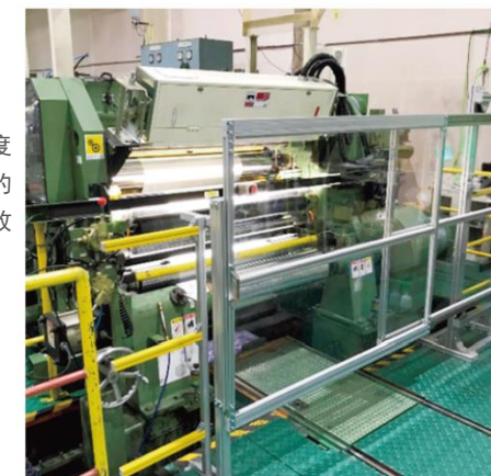
在生产设备上安装整体覆盖遮罩防止靠近
