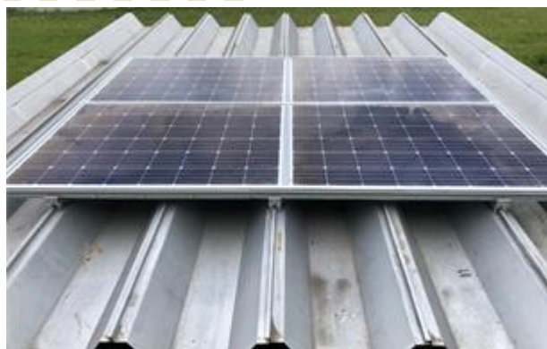
図1 折半屋根への設置
