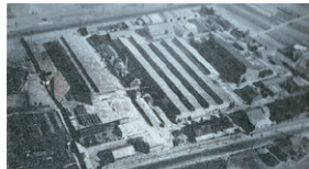
完成した八尾工場
